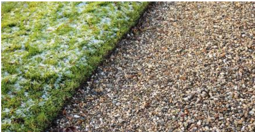
Afb. 23 Grindpaden gaan via een kantafsnijding over in gras wat een origineel detail vormt.
