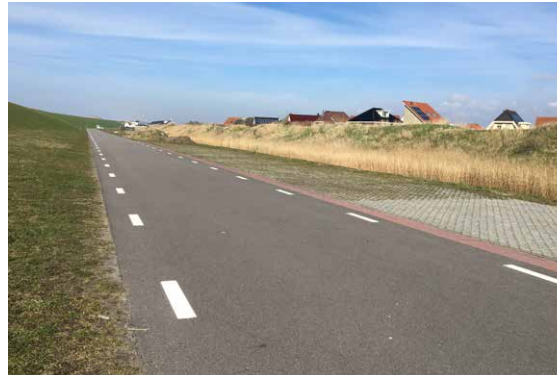
Reeds gerealiseerde ring in fase 1
