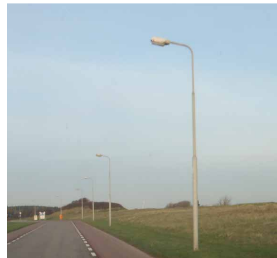
Standaard lichtmast 6 meter
