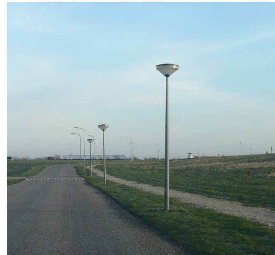
Standaard lichtmast 4 meter
