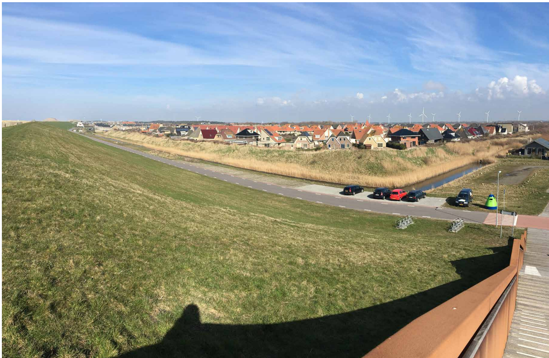
Parkeren langs Spreeuwendijk gerealiseerd
