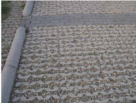
grasbetontegel ter plaatse van P1
