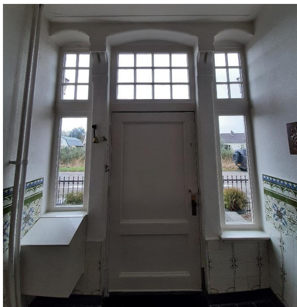
03 tussenpui uit de bouwtijd. Twee onderpanelen (1) zijn vermoedelijk aangepast
