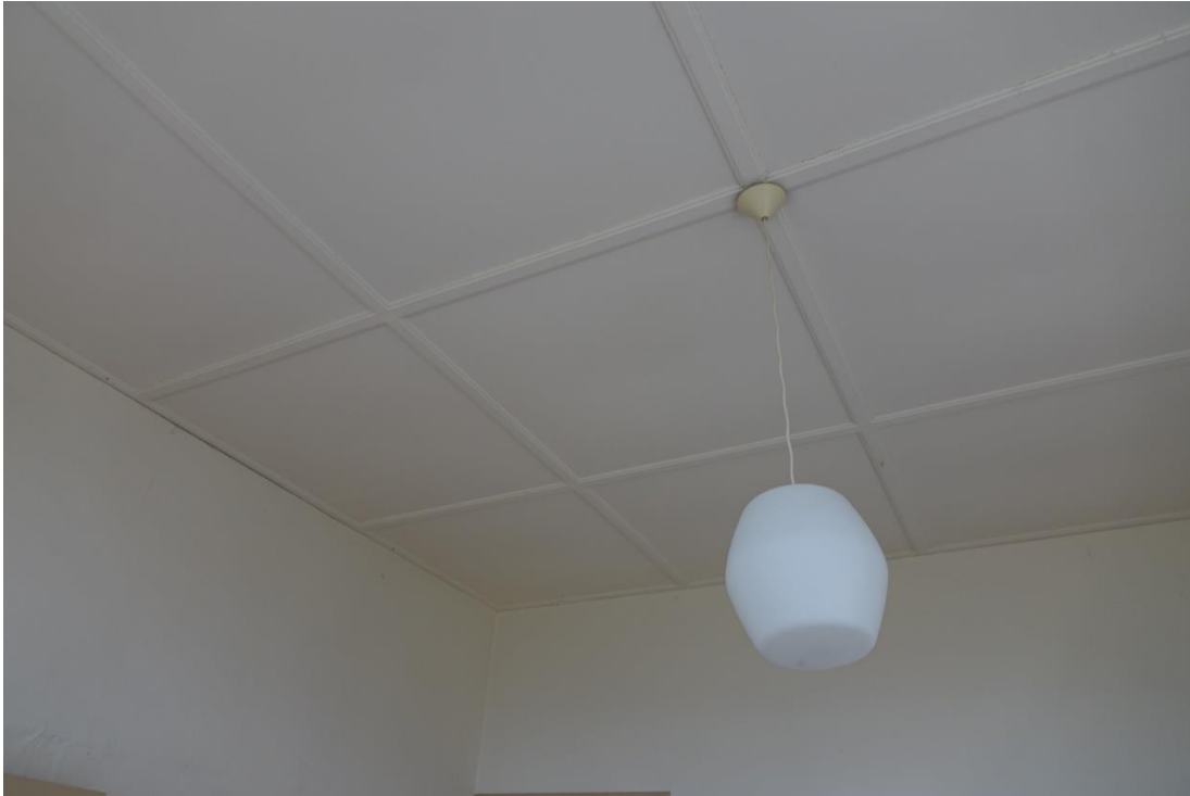
Boven: 10 historisch plafond uit 1937. De verfstructuur wijst erop dat het plafond mogelijk uit hardboard bestaat (niet uit te sluiten is, dat het om zachtboard gaat).
