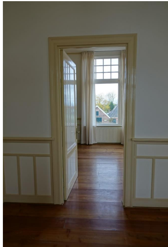
Boven: 05 Achterwand met portalen en deur naar de overloop. Linksonder: 11 fragment van een ondersteuk van een portaal. De lambrisering is rond 2000 aangebracht. Rechtsonder: 12 deur naar ruimte 1_4. De omlijsting en lambrisering zijn rond 2000 nagemaakt in de oorspronkelijke stijl van het huis.
