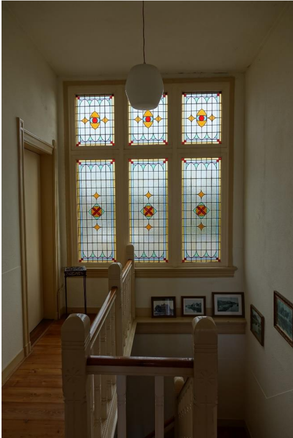
Linksboven: 05 Glas-in-loodvenster in de achtergevel. Rechtsboven: 10 geprofileerde vensterbank
