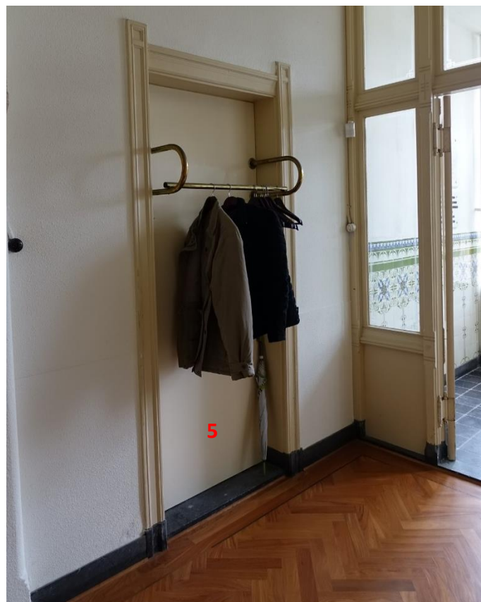
04b dichtgezette toegang naar woonkamer (5)
