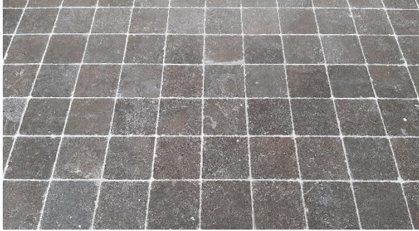
01 vloer (door huidige eigenaar gelegd)
