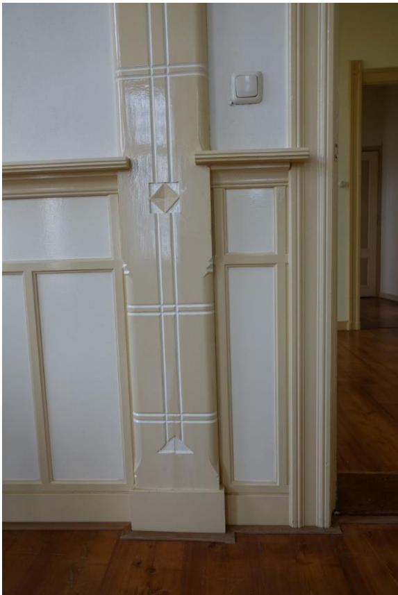
Boven: 05 Achterwand met portalen en deur naar de overloop. Linksonder: 11 fragment van een ondersteuk van een portaal. De lambrisering is rond 2000 aangebracht. Rechtsonder: 12 deur naar ruimte 1_4. De omlijsting en lambrisering zijn rond 2000 nagemaakt in de oorspronkelijke stijl van het huis.
