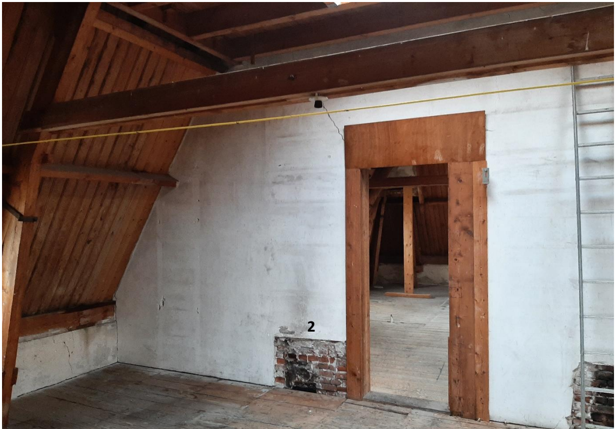
Boven: 05a achterwand van ruimte 2_2 met roetsporen van onbekende oorsprong (1) Onder 05b: achterwand met roetsporen van onbekende oorsprong (2 en 3)
