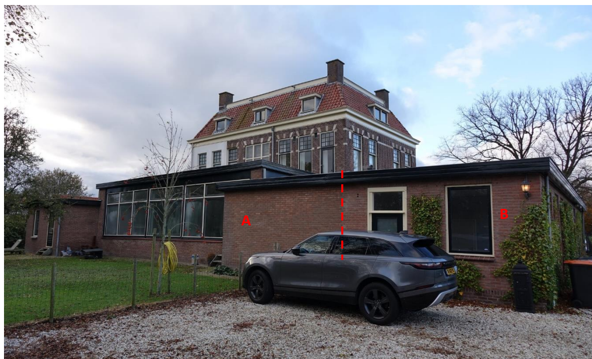
Boven: uitbreidingen aan de achterzijde. Een bouwnaad en kleurverschil in het metselwerk geven de overgang aan tussen fase 3 (A) en fase 4 (B). Zie de rode streeplijn. Op de achtergrond het hoofdgebouw uit 1908. De aanbouwen maken geen deel uit van de bescherming als rijksmonument
