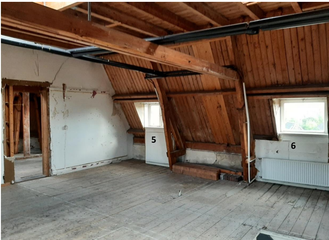
Onder: 04 kapconstructie aan de achterzijde. Deels oorspronkelijke dakkapellen (5) en (6), waarbij de ramen vernieuwd zijn zonder roedeverdeling
