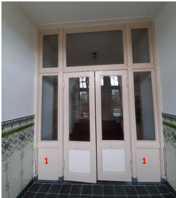
03 tussenpui uit de bouwtijd. Twee onderpanelen (1) zijn vermoedelijk aangepast
