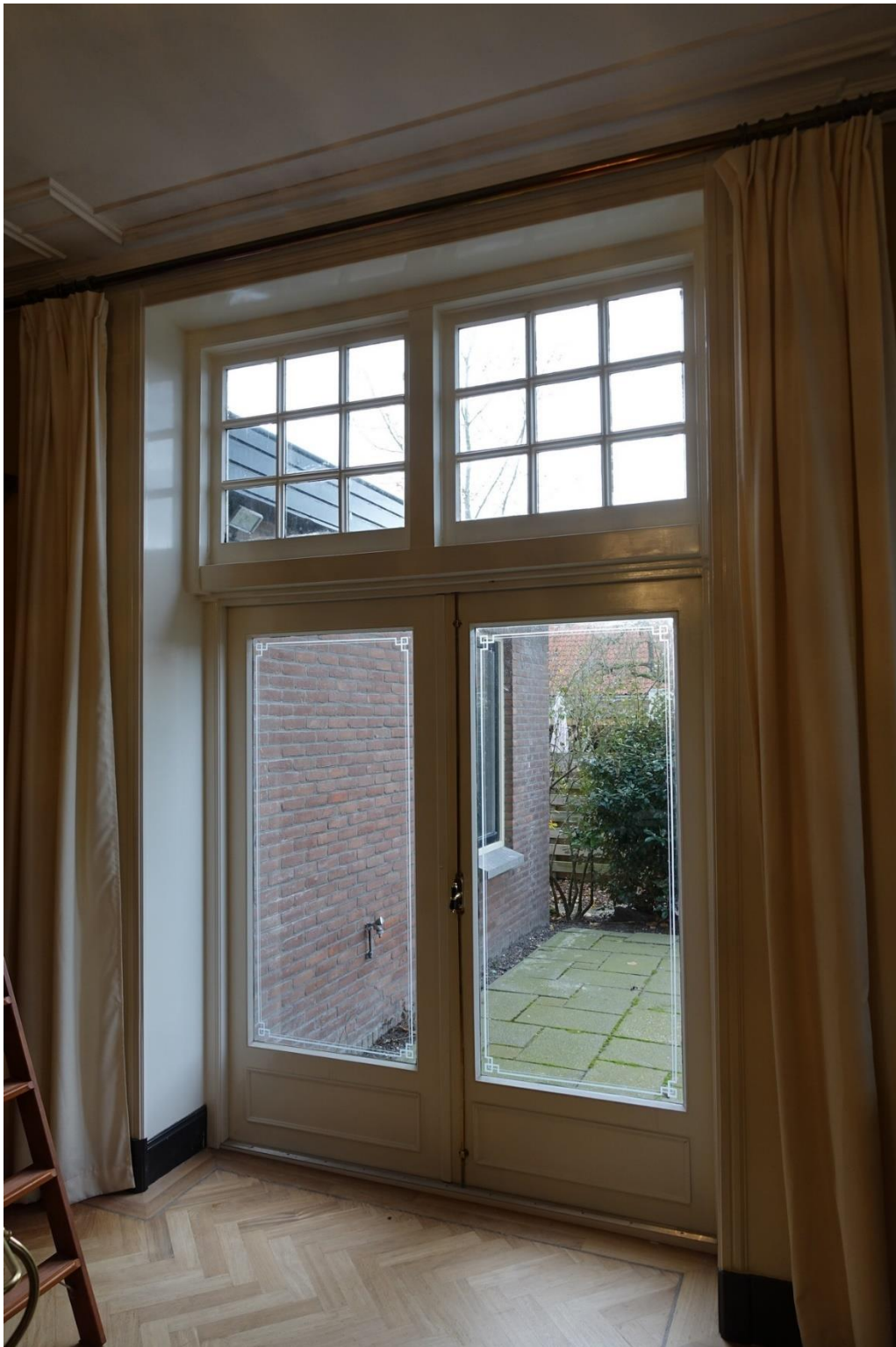
Boven: 12 close up van terrasdeuren met nieuw ingebrachte roeden en geplakte biezen (suggestie van geëët glas).
