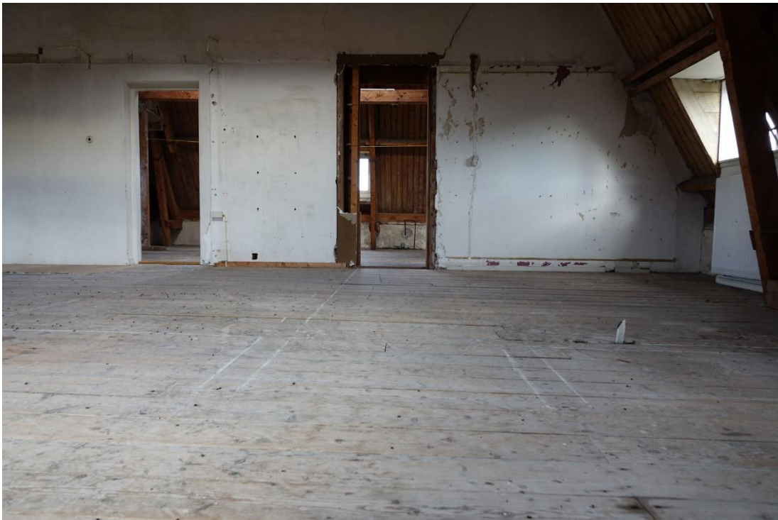
Boven: 03 tussenwand naar ruimte 2_2
