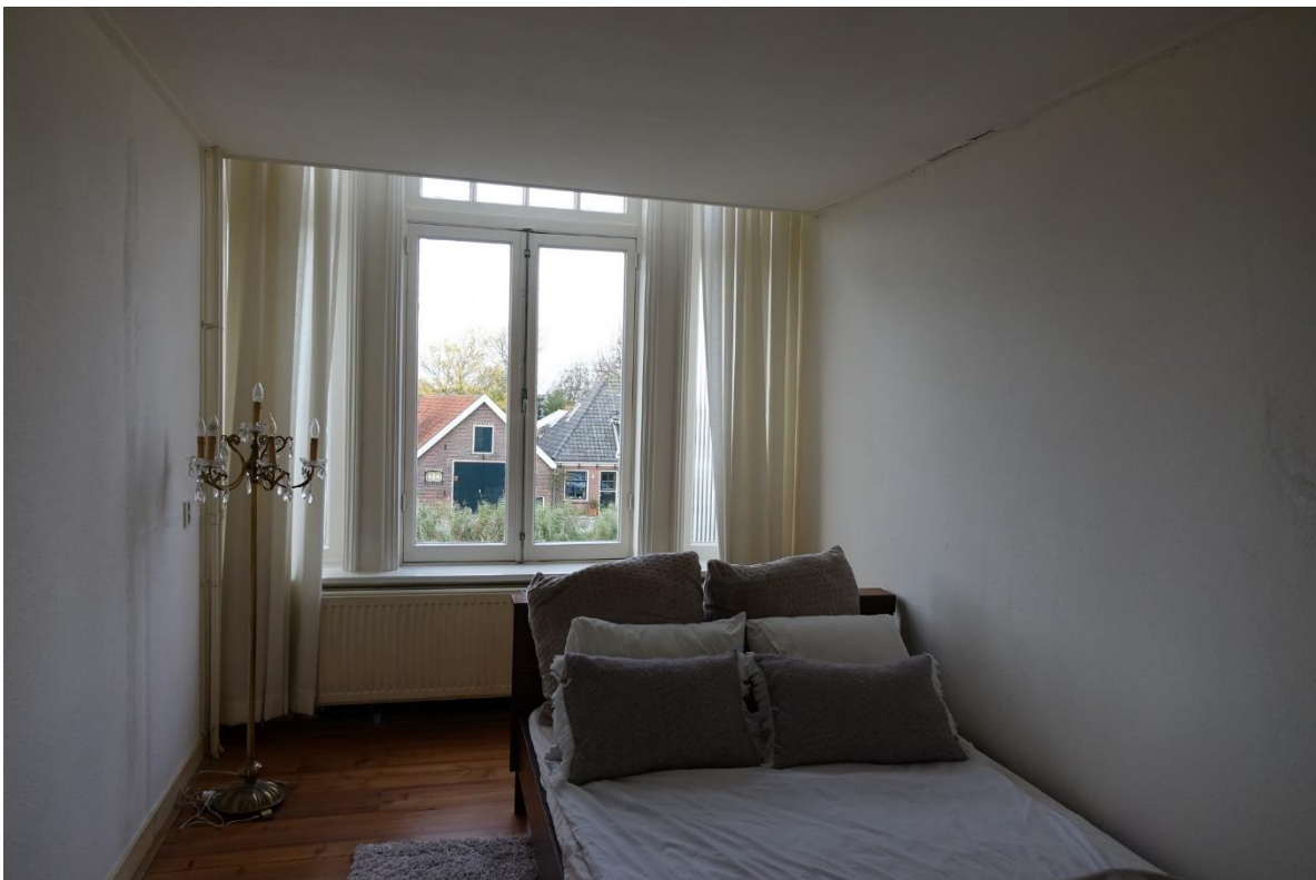
Boven: 03 Middelste slaapkamer met verlaagd plafond. In de gevel een zesdelig venster, waarin een stolpraam, twee smalle zijramen (achter de gordijnen) en drie bovenramen met roedeverdeling.
