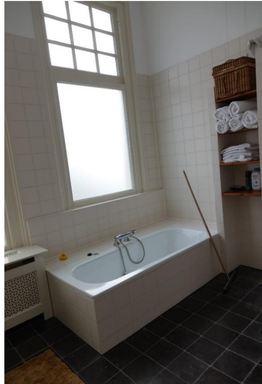
Rechtsboven: impressie badkamer. De onderdorpel van het raam werd verhoogd ten behoeve van het bad
