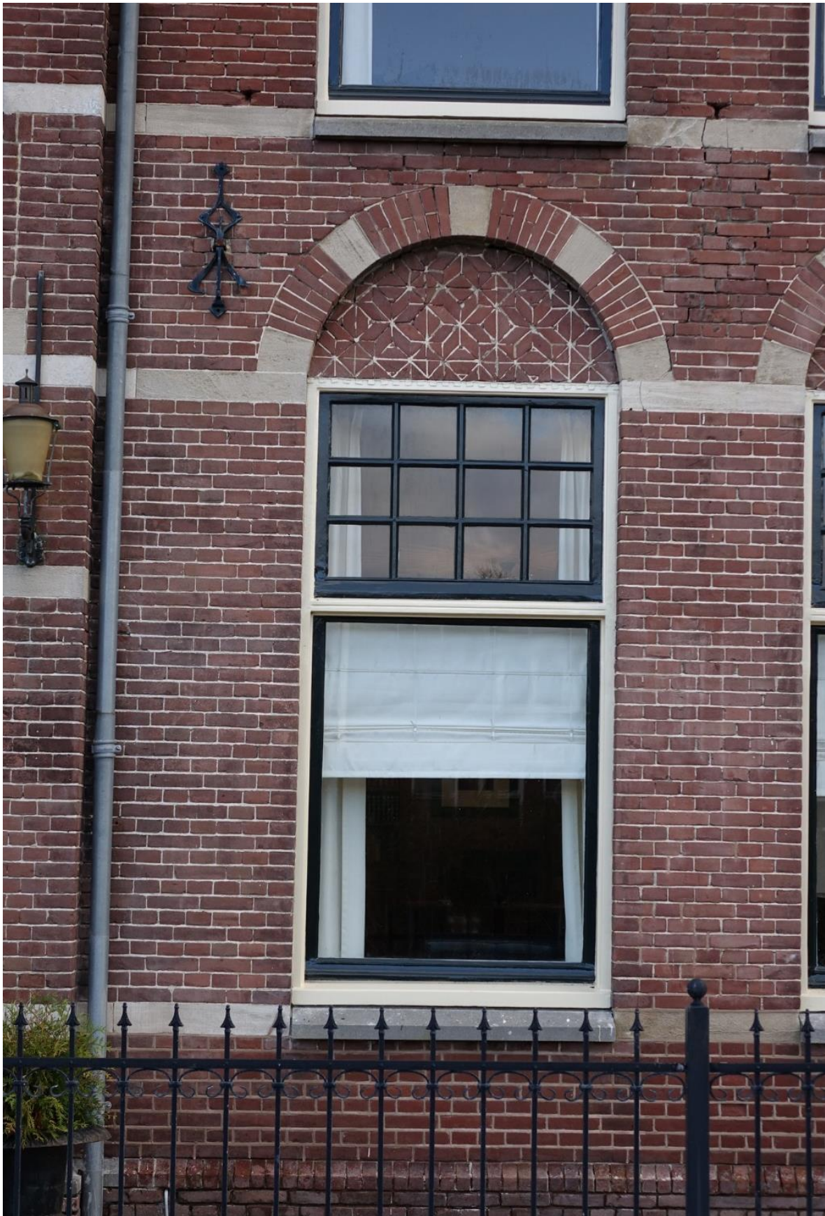
boven: fragment voorgevel t.p.v. de woonkamer. De roeden ter plaatse van de woonkamer zijn 20 jaar geleden opnieuw aangebracht (3 vensters in de voor- en rechter zijgevel) omdat deze niet meer aanwezig waren.
