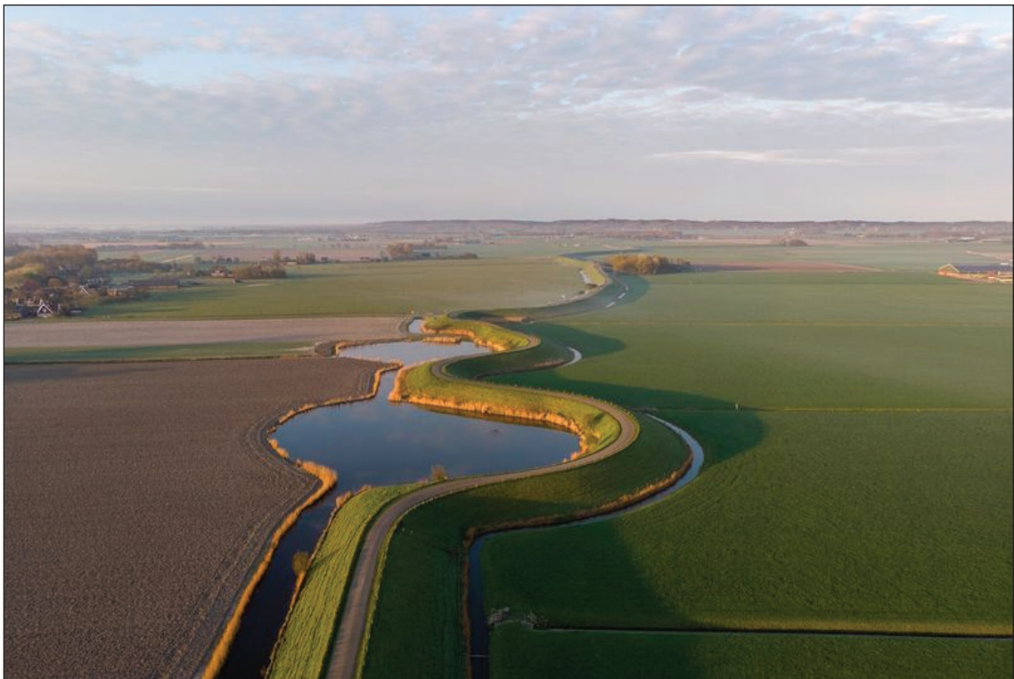
Afb. 18. De Westfriese Omringdijk vlakbij Eenigenburg. Op deze locatie zijn twee plekken te zien waar de dijk is doorgebroken. Na een dijkbreuk werd de dijk om de wielen (een doorbraak- of kolkgat) heen gelegd, waardoor een slingerende dijk is ontstaan.
