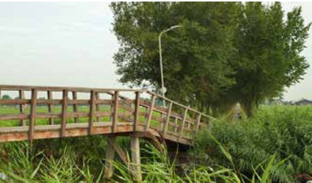
Houten voetgangersbrug ( voorbeeld Waarland)
