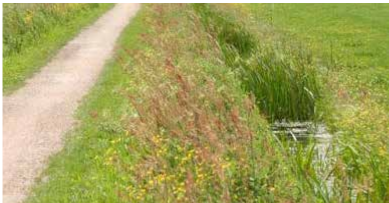
Struipad langs sloot richting de molen met halfverharding
